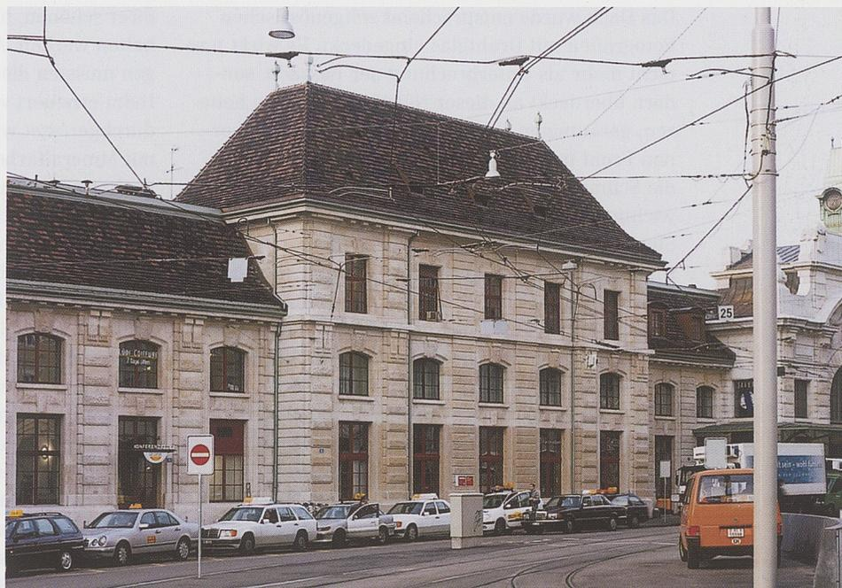
ganze Blöcke ersetzt werden, wozu ursprüngliches Material aus Laufen eingesetzt werden konnte. Grösstenteils wurden die Fehlstellen aber mit einem eigens entwickelten, mineralischen Mörtel aufmodelliert.
